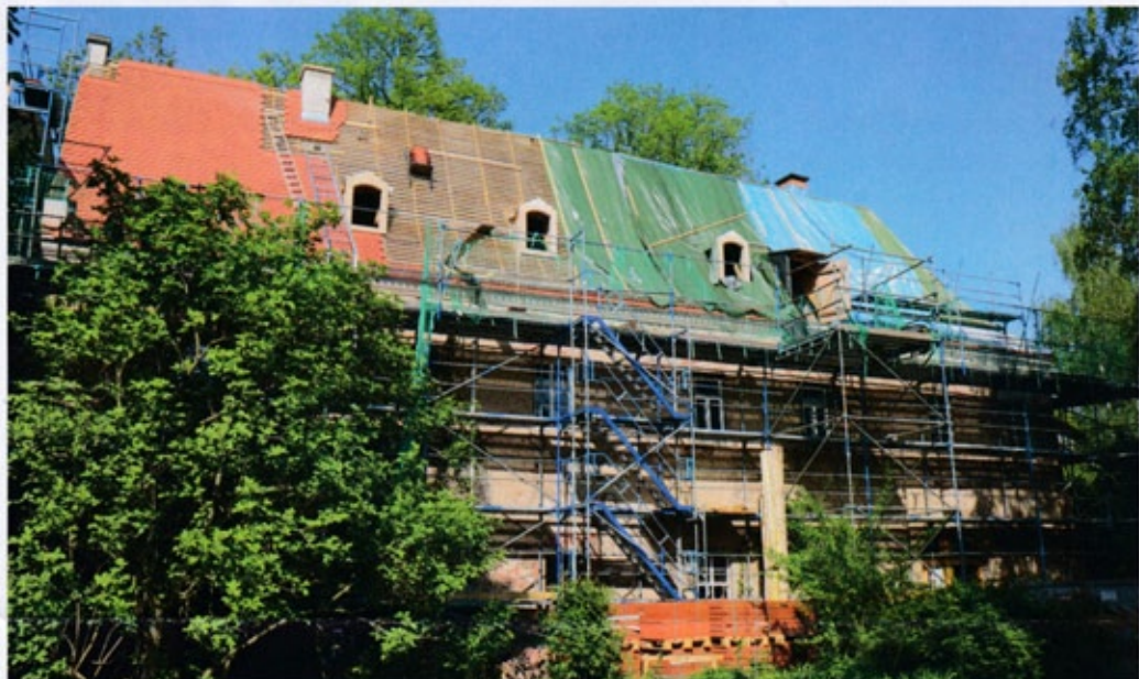
Jahnishausen wird gesichert: Allein die Erneuerung des Daches kostet fast vierhunderttausend Euro.
