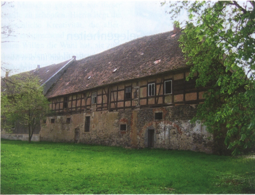
Das Fachwerkhaus mit 900 qm Nutzfläche ist nach seiner Renovierung für die älteren Mitglieder der Lebensgemeinschaft vorgesehen.
